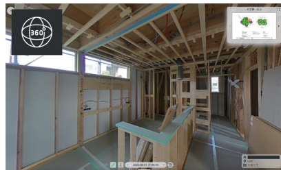
360度カメラ+専用アプリで建築現場をVR化できる「Log Walk」。ステークホルダー全員が遠隔で確認を確認できる
