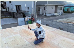
スタジオセンスの大工が撮影した360度写真とビデオ通話により、log buildのオペレーターが遠隔でチェックを行う
